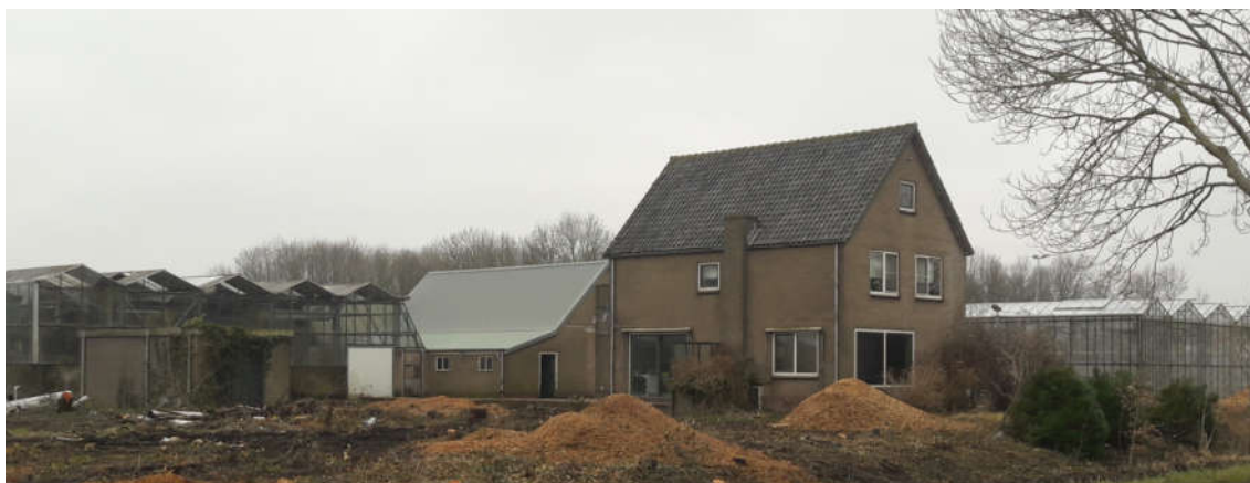
Afbeelding 2.1: Foto bestaande situatie
