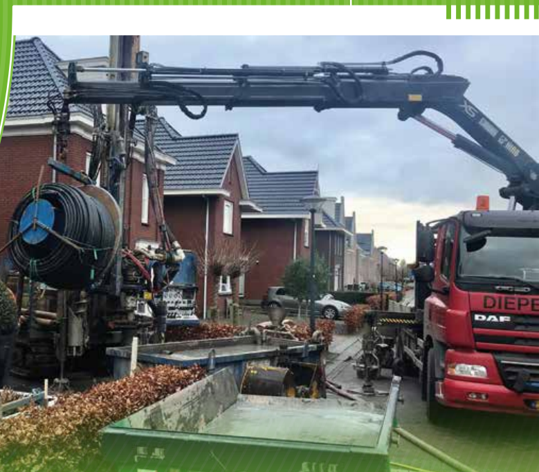
Installatie bodemenergiesysteem bij een bestaande woning
