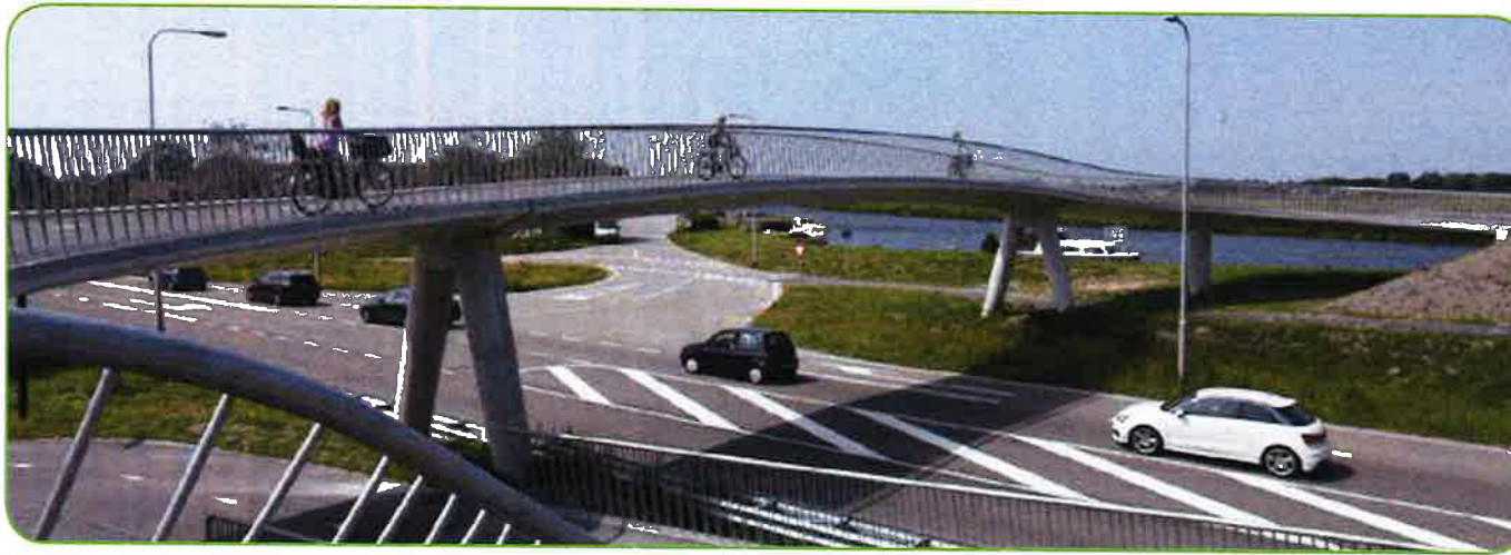
Het duurzaam oplossen van de verkeersknoop. Fietsbrug De Krul, de verbinding tussen gemeente Langedijk, Broekhorn en het Heerhugowaardse stationsgebied.
