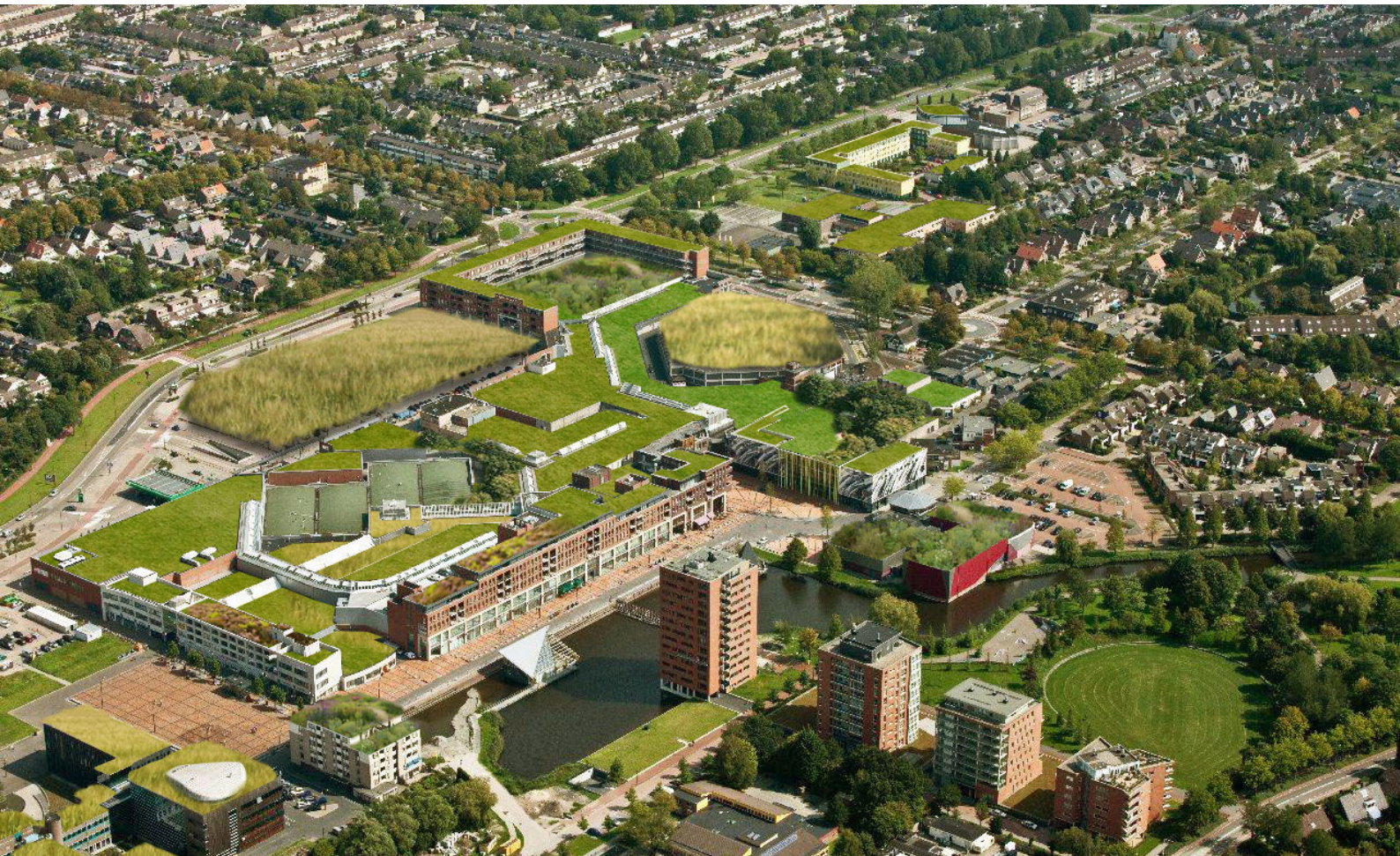
Groene daken op de Middenwaard, Gemeentehuis en andere centrale gebouwen
