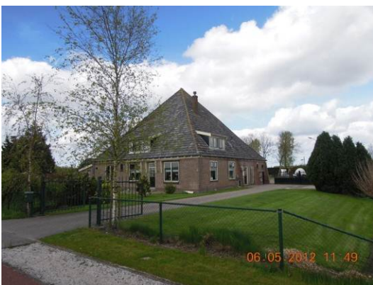
Jan Glijnisweg 1 (stolp op redelijk ruim erf)
