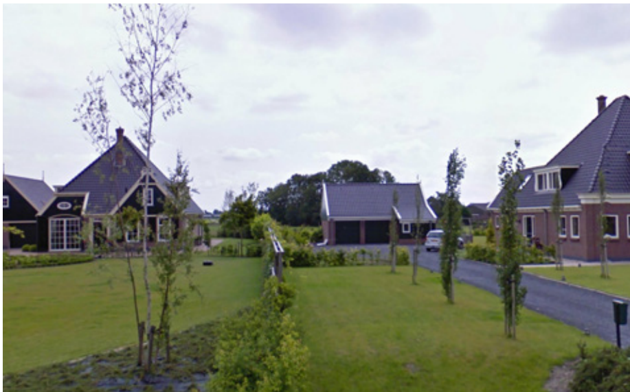
Ensemble hoofdvolume en bijgebouw
