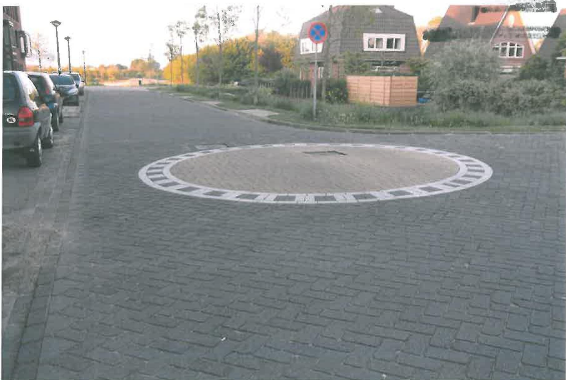
FOTO 2: 'Drempels' op de Prisma, die het verkeer op geen enkele manier afremmen, omdat ze veel te laag zijn.
