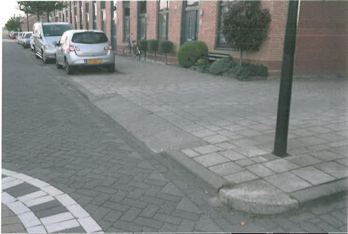
FOTO 6 t/m 13: Bij het in- en uitrijden van deze steeg is er geen zicht op de weg, wat tot hele gevaarlijke situaties leidt!
