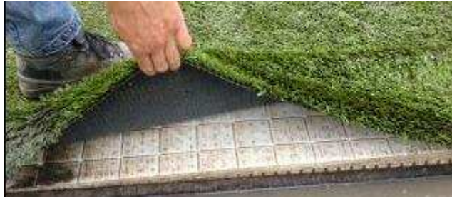
Figuur 2: Voorbeeld Operationele inspectie
