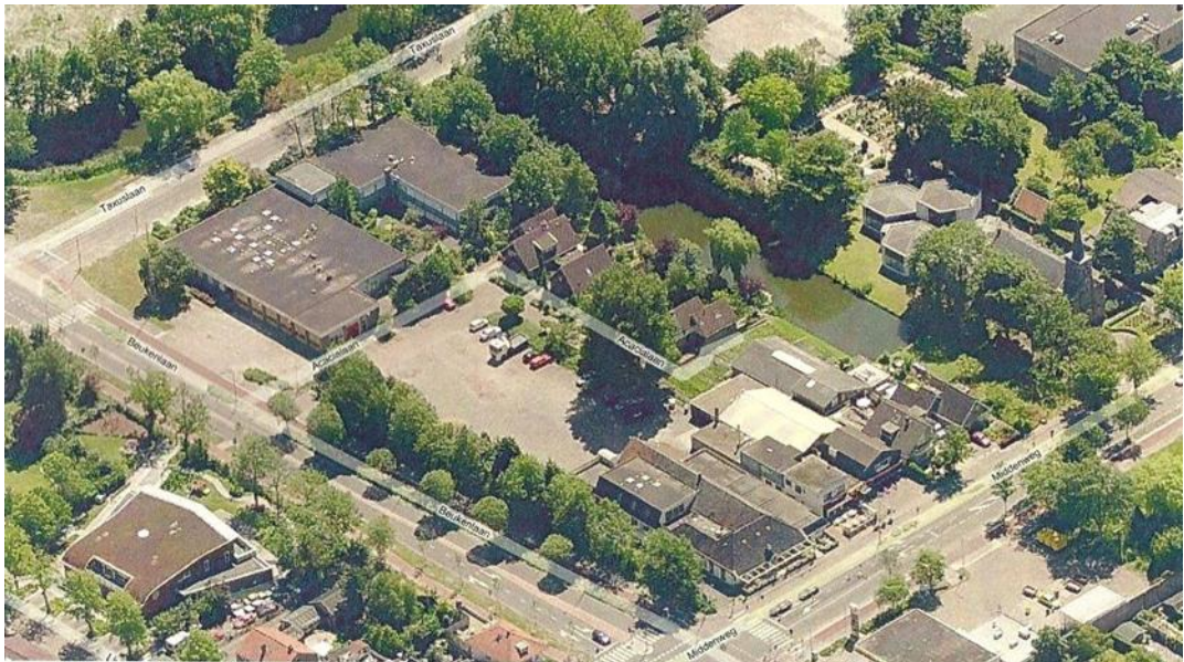
Figuur 1 luchtfoto bestaande situatie
