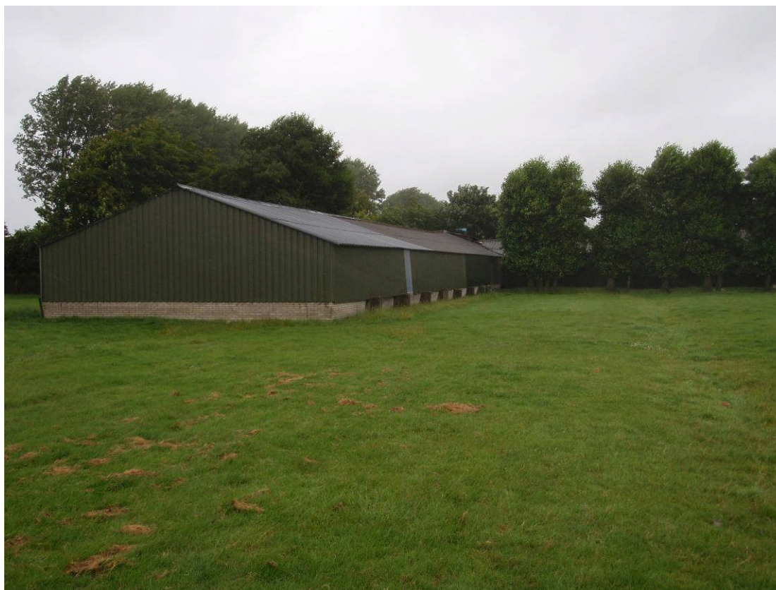
Foto 12: weiland en schuur
