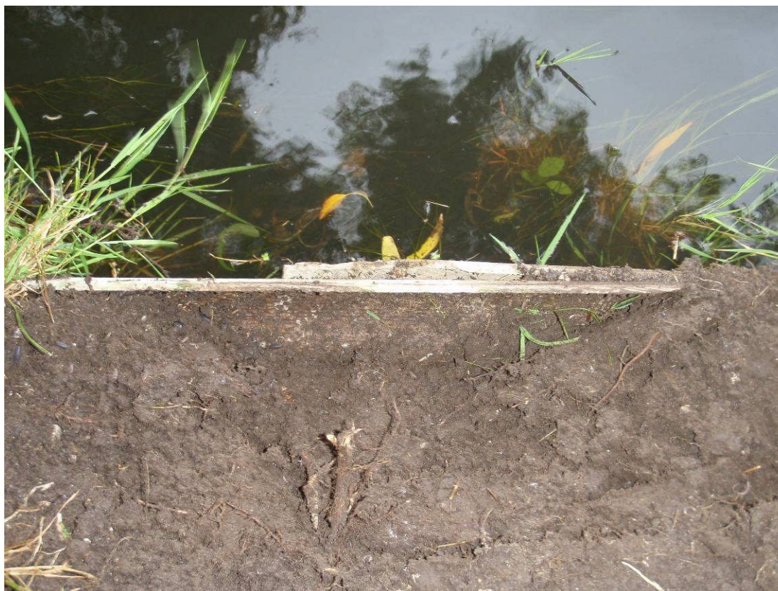
Foto 8: asbestverdachte schoeiing
