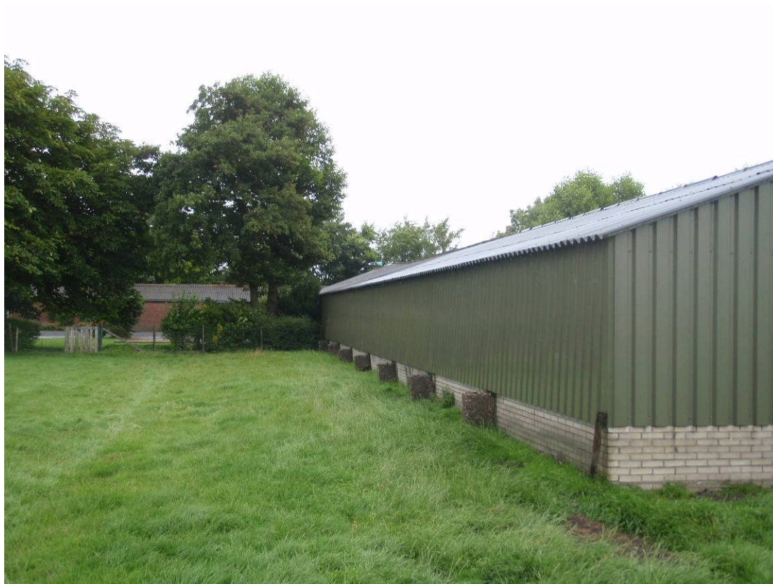
Foto 13: weiland en schuur
