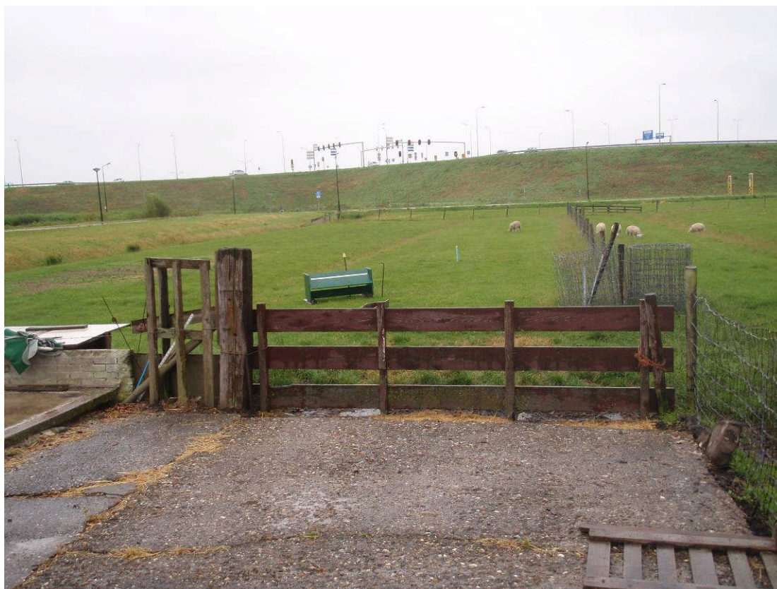
Foto 10: weiland en betonverharding
