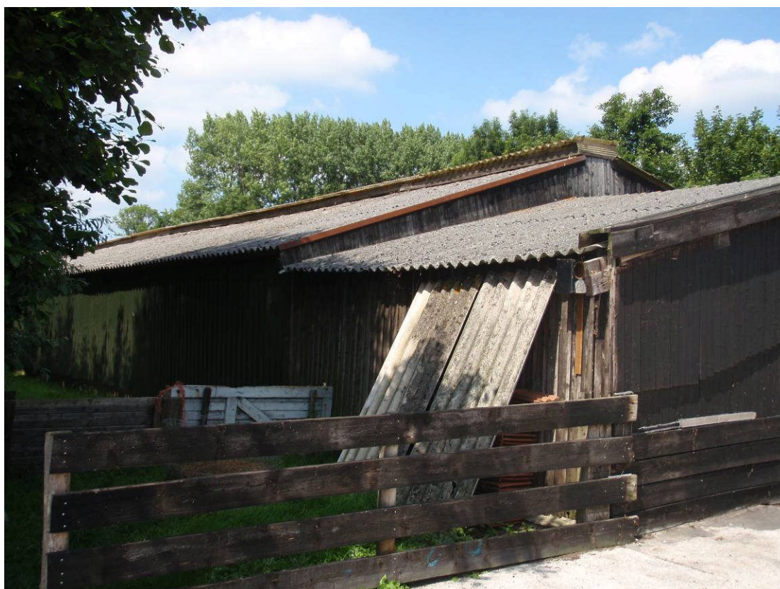
Foto 2: asbestverdachte platen
