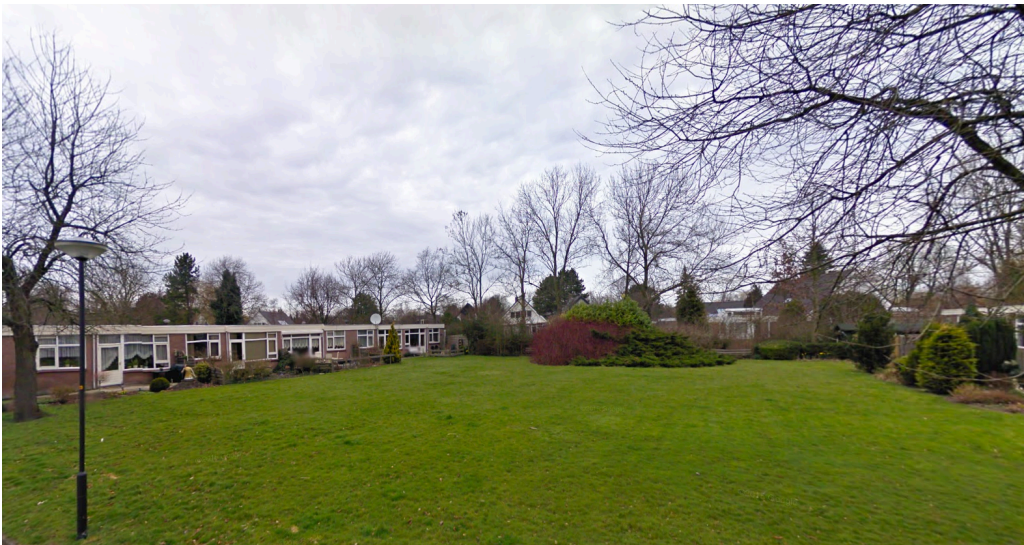
Figuur 2 De woningen aan het Gerard Douplantsoen zijn gesloopt. Woningcorporatie Woonwaard is voornemens om op de locatie nieuwe woningen te realiseren (bron afbeelding: Google Streetview 2009).
