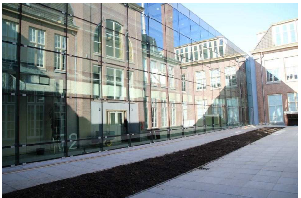
Het nieuwe depotgebouw
