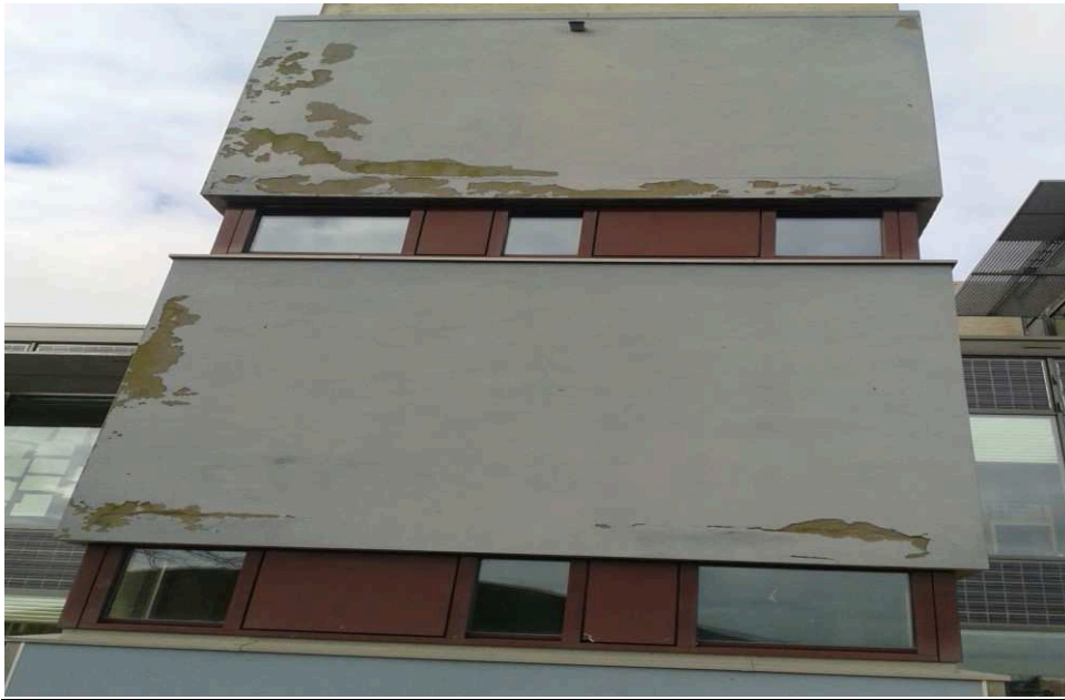
Foto stucwerk achterzijde
