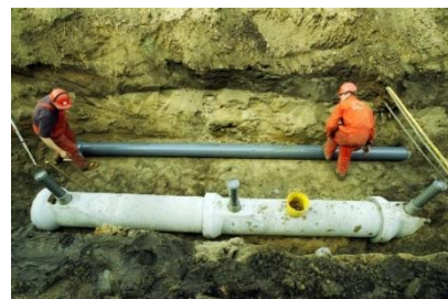
Figuur 2: Gescheiden rioelstelsel (RIONED)
