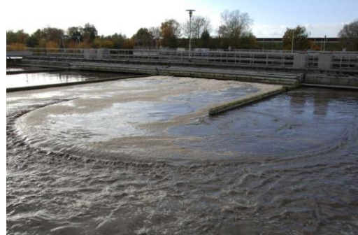
Figuur 1: Rioolwaterzuiveringsinstallatie (RIONED)
