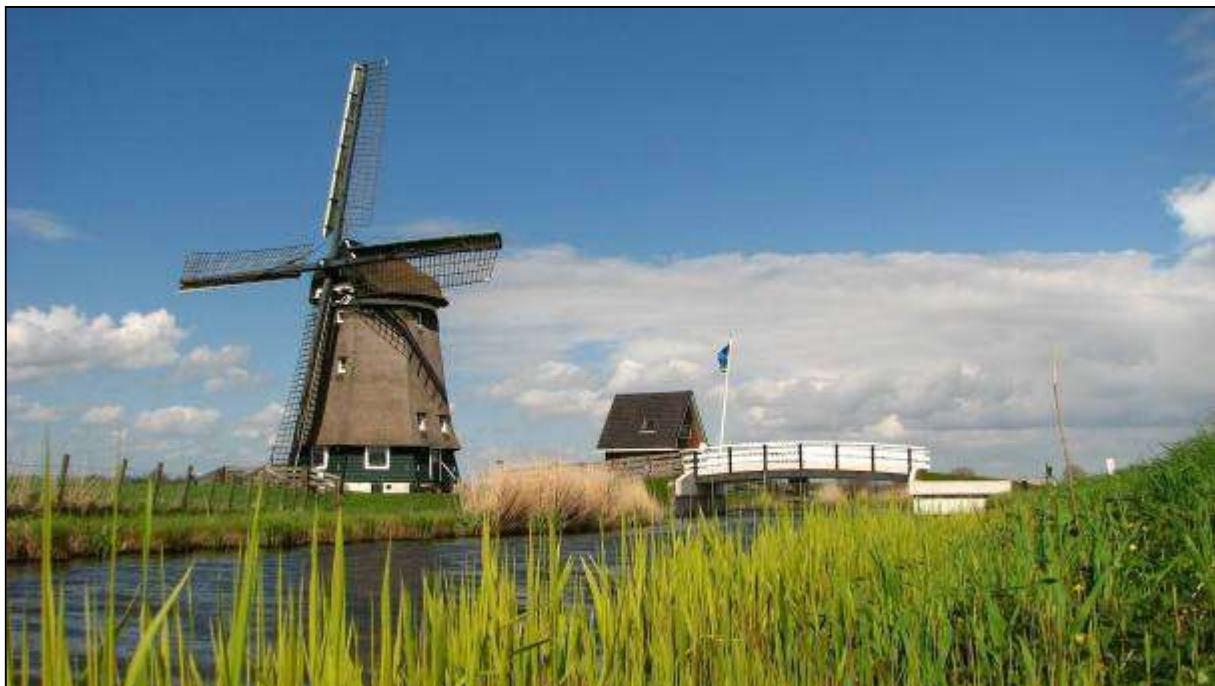
Afb. 23: De “Veenhuizer” uit 1603, op deze foto gezien vanaf de andere kant van de ringvaart, is de enige molen die nog op het grondgebied van de gemeente Heerhugowaard staat. Oorspronkelijk waren alleen al voor het drooghouden van de Heerhugowaard 47 molens nodig.
