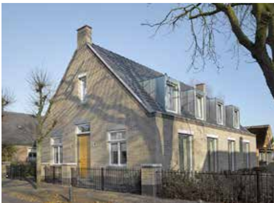
dakopbouwen in de goot zinkbekleding
