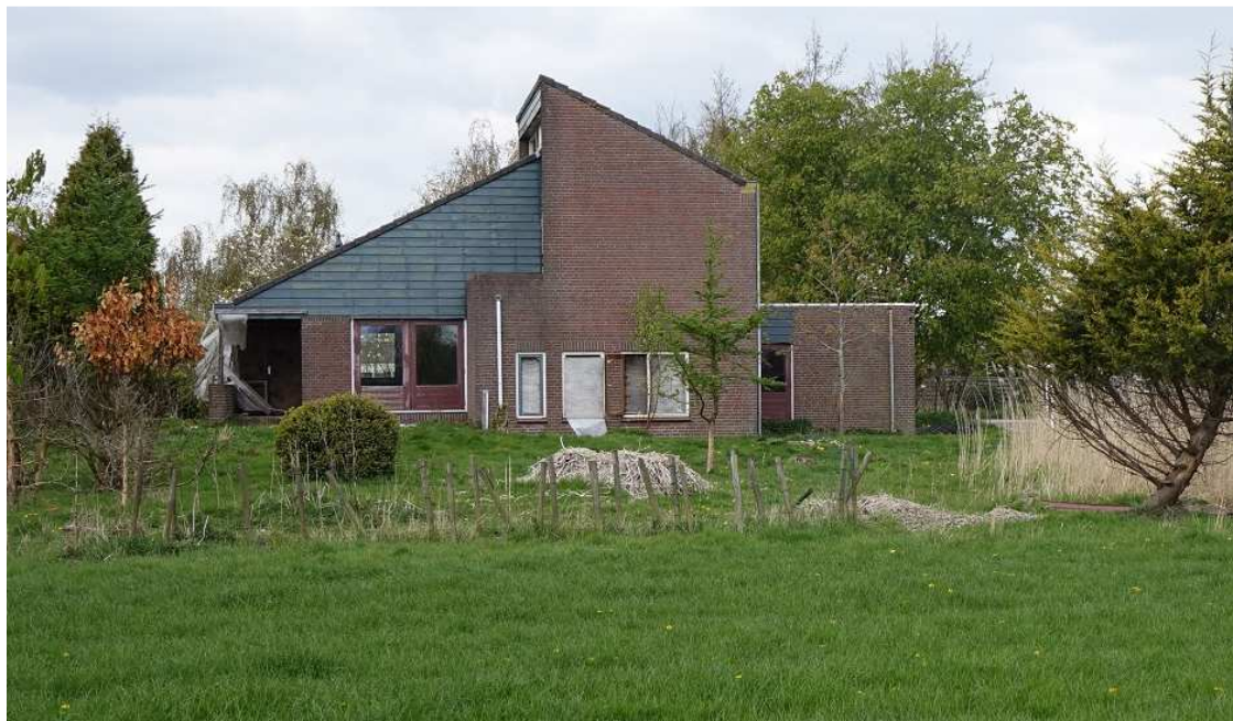
Figuur 6. Te slopen woonhuis aan de Jan Glijnisweg te Heerhugowaard
