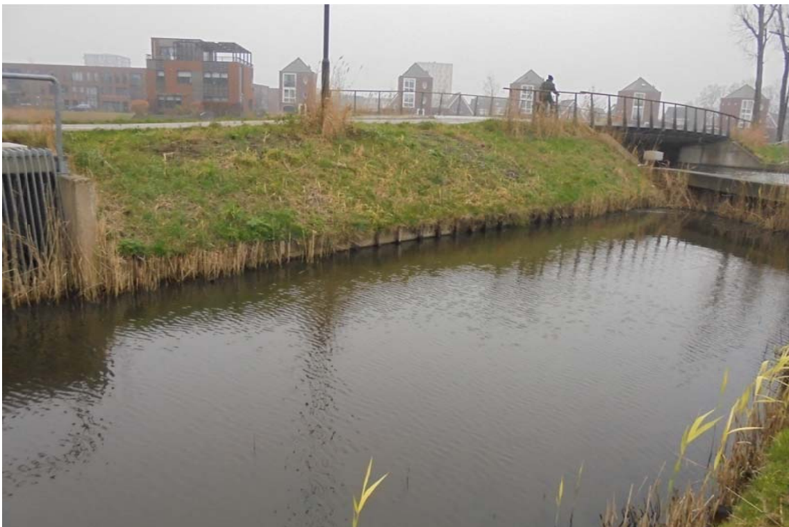
Houten beschoeiing bij brug (bij DWP4-1, westelijke zijde)
