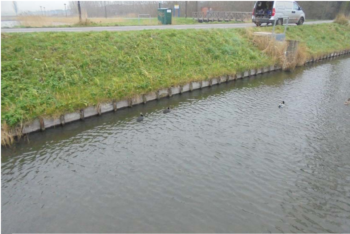
Houten beschoeiing bij brug (bij DWP8-1, oostelijke zijde)
