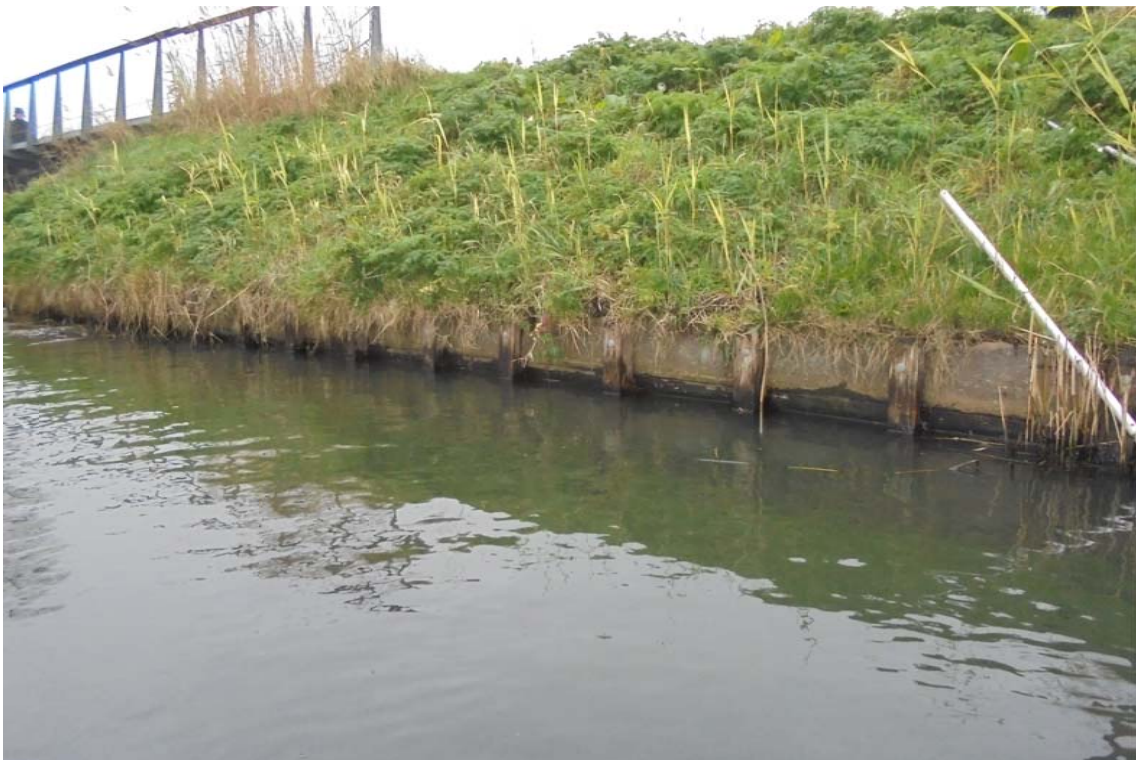
Houten beschoeiing bij brug (bij DWP3-8, westelijke zijde)
