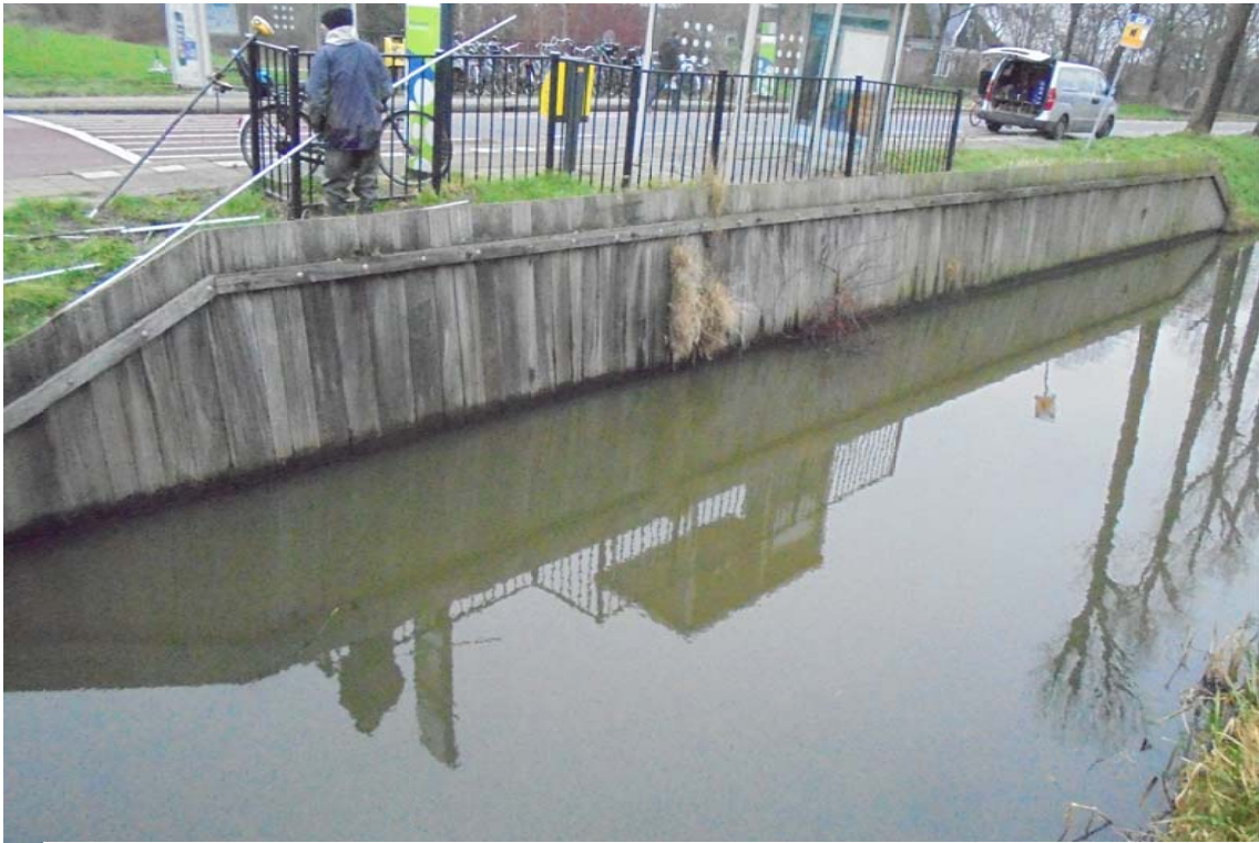
Houten beschoeiing bij bushalte (bij DWP7-4, oostelijke zijde)
