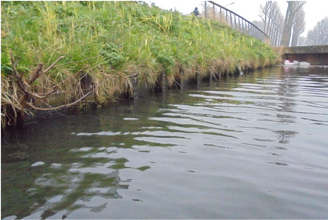
Houten beschoeiing bij brug (bij DWP7-8, oostelijke zijde)
