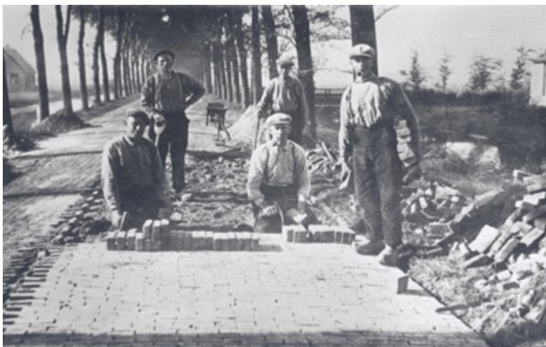
Figuur 1: aanleg klinkerverharding
