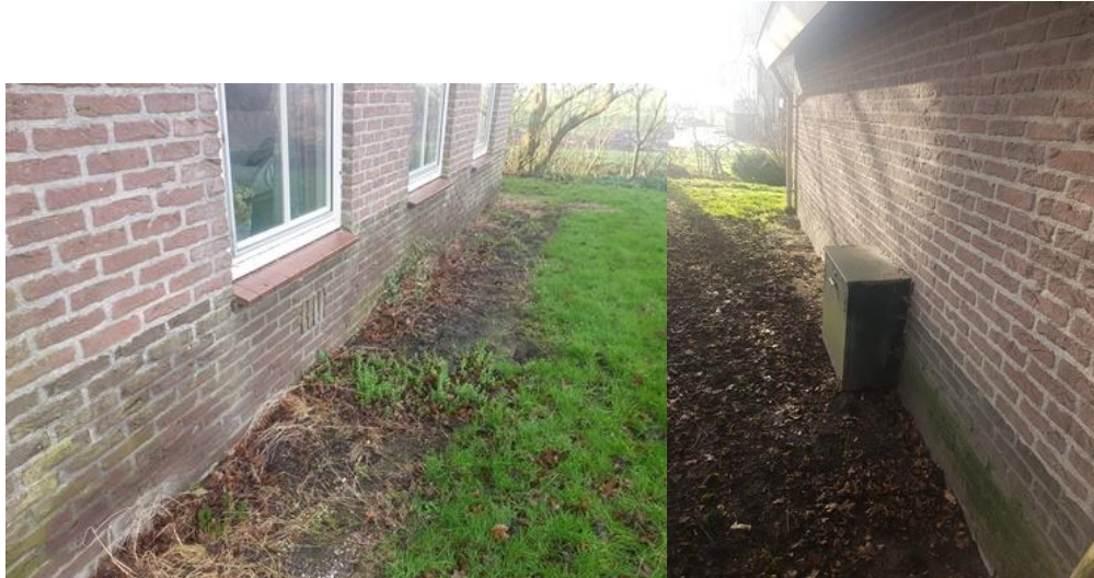
Detailopnames van de te slopen woning in het plangebied.
