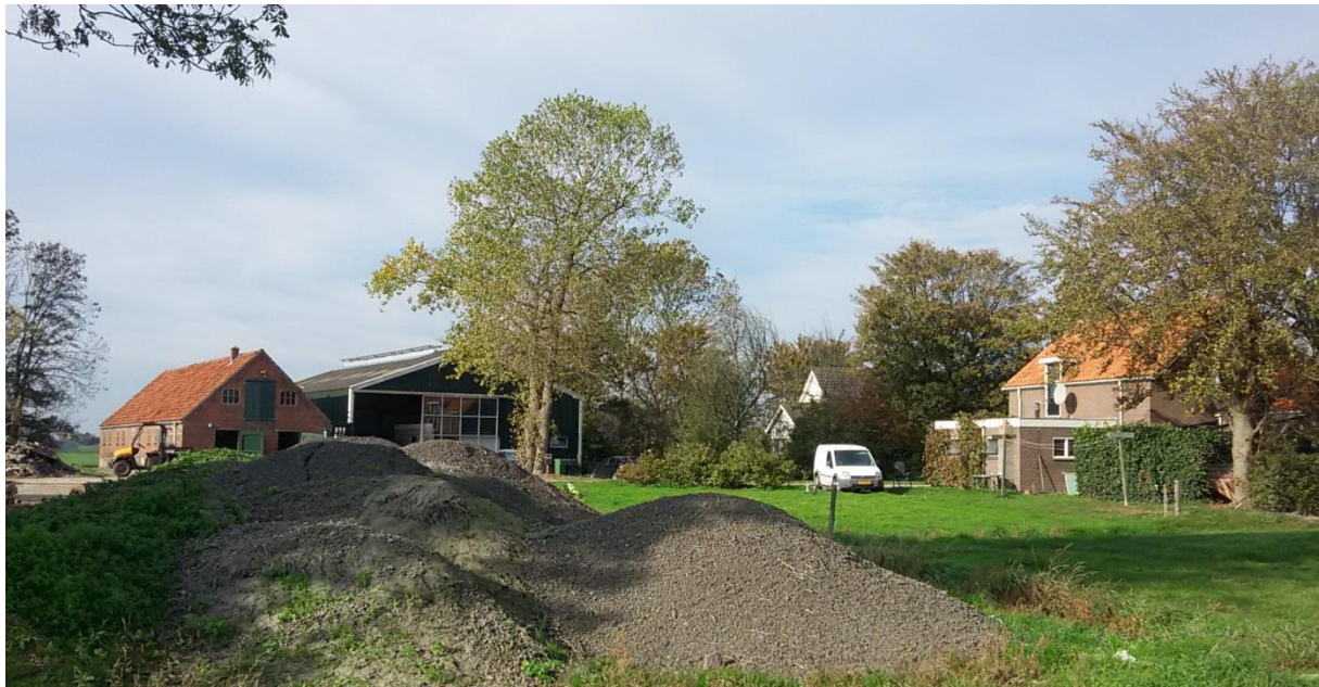
Figuur 2. De agrarische bedrijfsgebouwen op het achtererf van de A. C. de Graafweg 8-8a.
