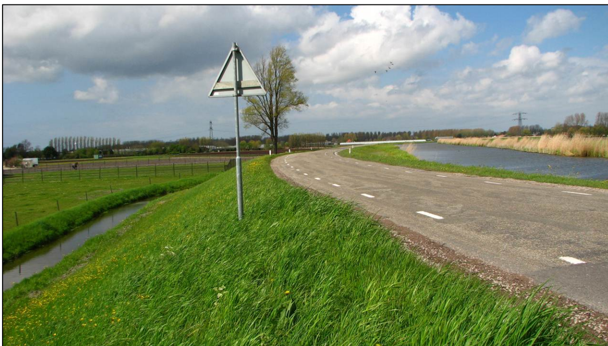
Afb. 23: De ringdijk en -vaart van de polder Heerhugowaard gezien vanaf de Oostdijk. Links van de dijk ligt het lage land van de polder en rechts het hoge water in de ringvaart, dat in plaats van de oorspronkelijke waterboezem voor de afwatering van de polder moet zorgen.
