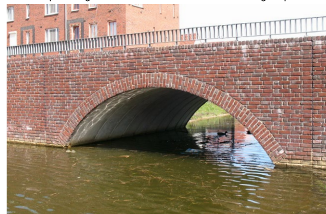
watergangen: duiker met gemetselde zijanten
