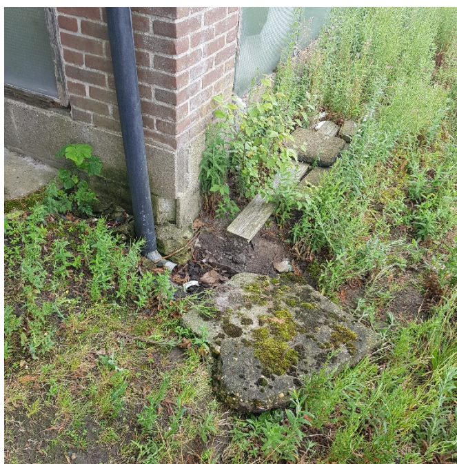
Foto 6. Infiltratie van hemelwaterafvoer in bodem (E01)
