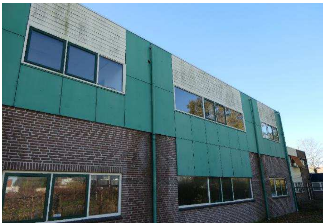
Achterzijde van Deimoslaan 5 waarbij muren, kozijnen, beplating, houten betimmering en metalen dakranden te zien zijn.
