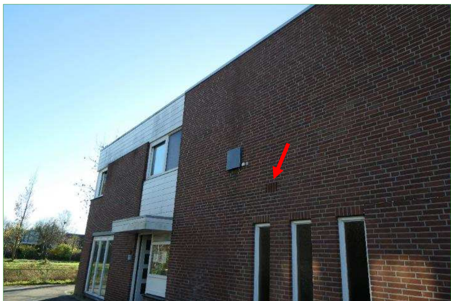
Gaten (ventilatierooster) in de muur bij Hectorlaan 17-19 die mogelijk toegang geven tot voor vleermuis .geschikte achterliggende ruimtes.
