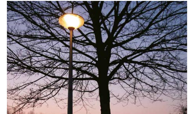
lichtmast met paaltoparmatuur: Lightronics - KFK
