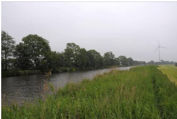
Kanaal Alkmaar (Omval)-Kolhorn t.h.v. de brug
