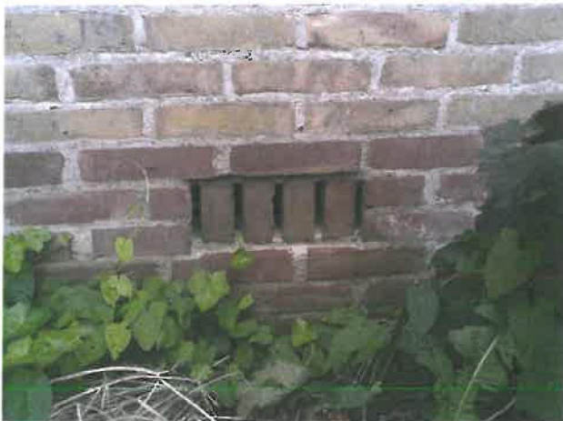
Huis heeft spouwmuren, mogelijk toegankelijk voor vleermuizen?
