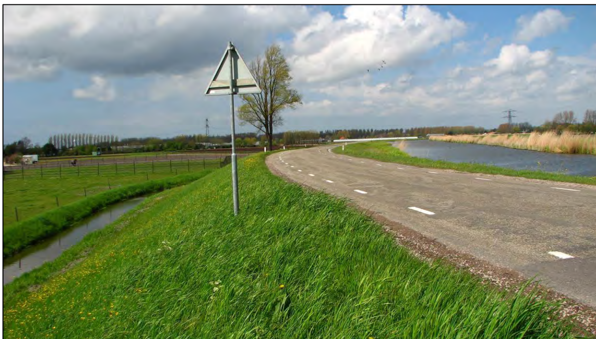
Afb. 23: De ringdijk en -vaart van de polder Heerhugowaard gezien vanaf de Oostdijk. Links van de dijk ligt het lage land van de polder en rechts het hoge water in de ringvaart, dat in plaats van de oorspronkelijke waterboezem voor de afwatering van de polder moet zorgen.
