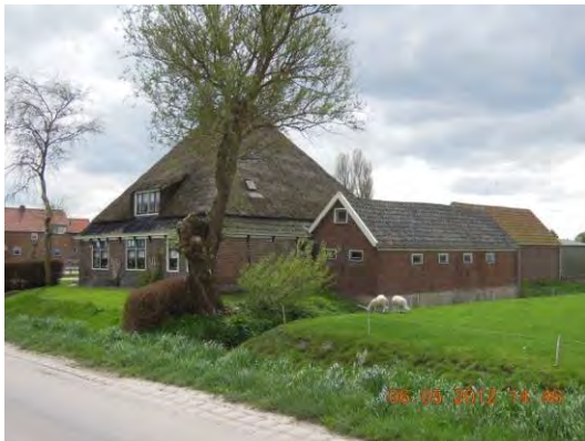
Veenhuizerweg 21, stolpensemble op ruim erf
