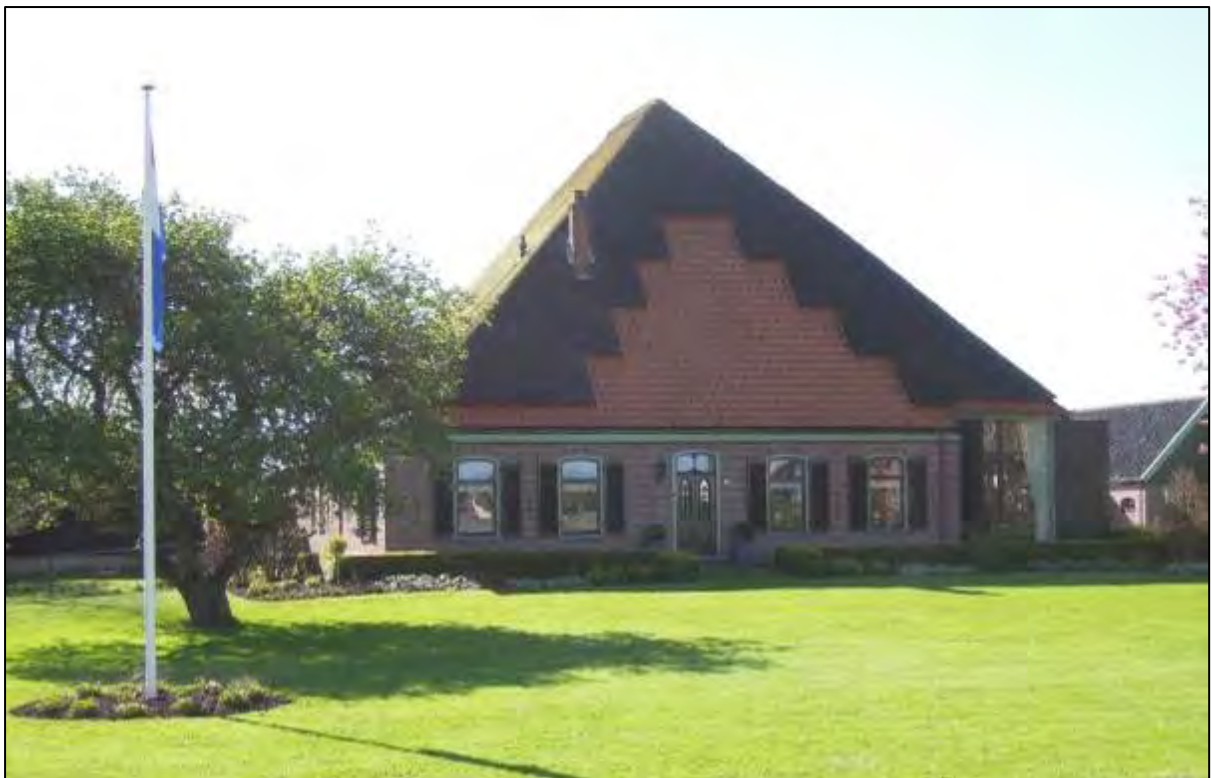
Afb. 36: Aan de Middenweg 6, staat een oude stolpboerderij met een getrapte dakspiegel en waarin een oudere kern aanwezig is, dan deze vanaf de buitenkant doet vermoeden.
