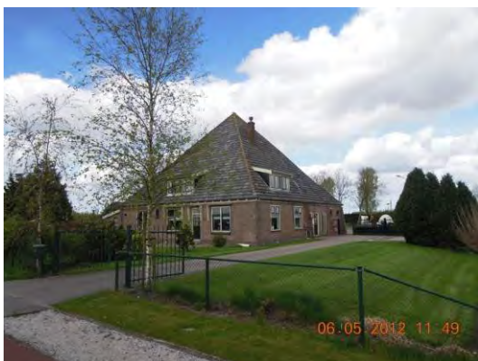
Jan Glijnisweg 1 (stolp op redelijk ruim erf)
