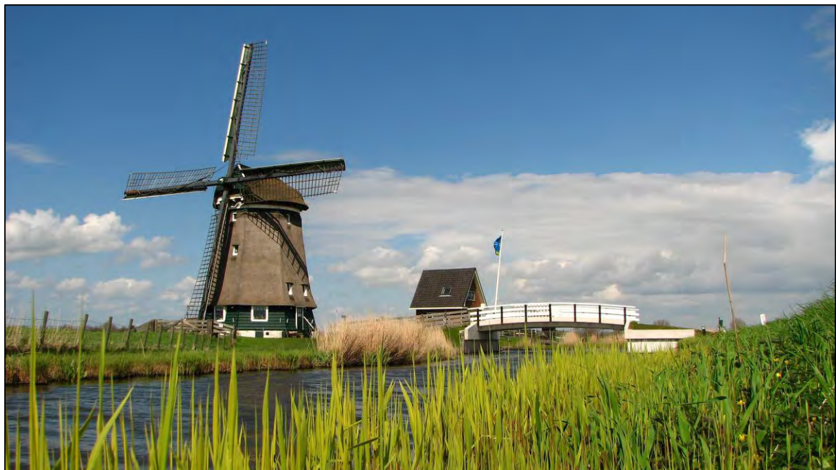
Afb. 24: De “Veenhuizer” uit 1603, op deze foto gezien vanaf de andere kant van de ringvaart, is de enige molen die nog op het grondgebied van de gemeente Heerhugowaard staat. Oorspronkelijk waren alleen voor het drooghouden van de Heerhugowaard al 47 molens nodig.
