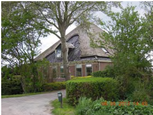
Veenhuizerweg 29, stolp met klokvormige spiegel
