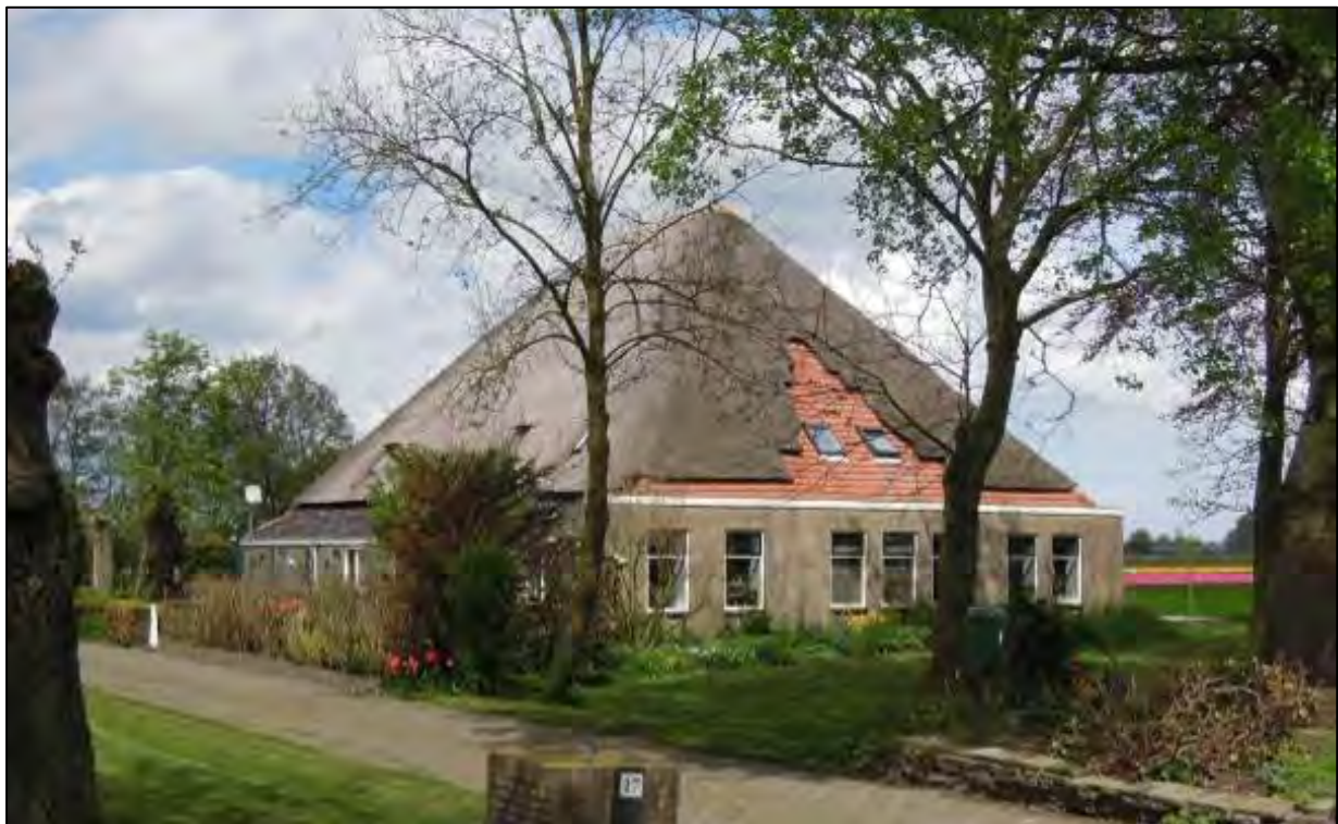
Afb. 18: De Kerkweg 17 is één van de drie stolpboerderijen in Veenhuizen, die mogelijk nog een historische vierkantconstructie bevat.
