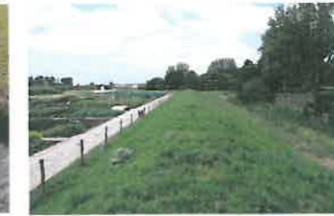
kantelkade als begrenzing van het volkstuincomplex
